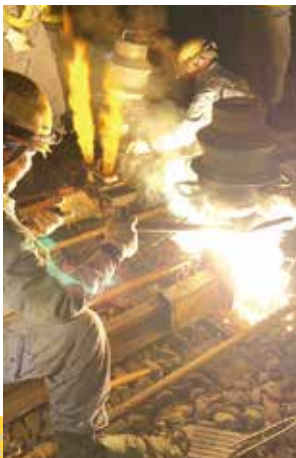
左: レールの間の型に溶かした金属を流し込んでいる様子
