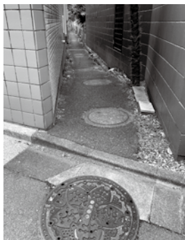
百々向川上流部の暗渠(赤塚新町3丁目)
