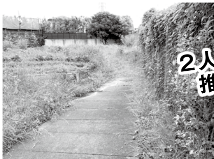
前谷津川の蓋暗渠 (新河岸1丁目)
