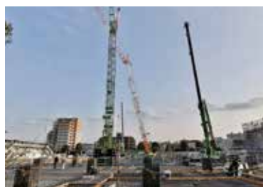
練馬光が丘病院の建設現場 (3月19日撮影 秋の陽公園から)
